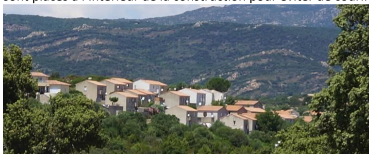
Les paraboles en toiture au Piattone
