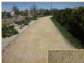
Stabilisé mécaniquement « STABILISÉ CALCAIRE »
