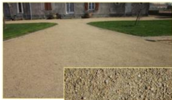
Stabilisé mécaniquement « CHAPE »
