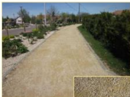
Stabilisé mécaniquement « STABILISÉ CALCAIRE »
