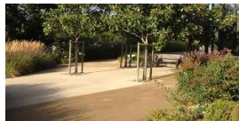
< Exemple de sol drainant stabilisé
