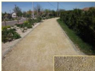
Stabilisé mécaniquement « STABILISÉ CALCAIRE »
