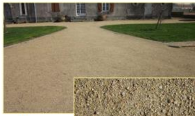
Stabilisé mécaniquement « CHAPE »
