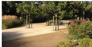
< Exemple de sol drainant stabilisé
