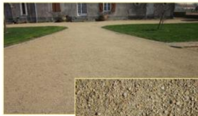
Stabilisé mécaniquement « CHAPE »
