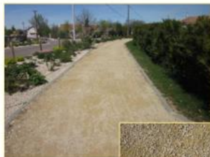
Stabilisé mécaniquement « STABILISÉ CALCAIRE »
