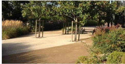
< Exemple de sol drainant stabilisé
