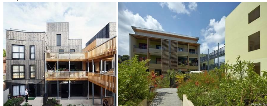
Exemples de bâtiments avec coursive extérieure
