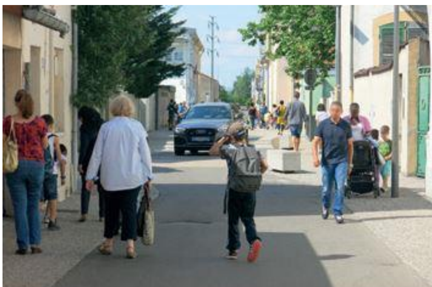
Exemple d'une zone de rencontre à proximité d'une école. Le dessin de la chaussée est sinueux et du mobilier y prend place. Cela oblige les automobilistes à zigzaguer et donc à ralentir.
