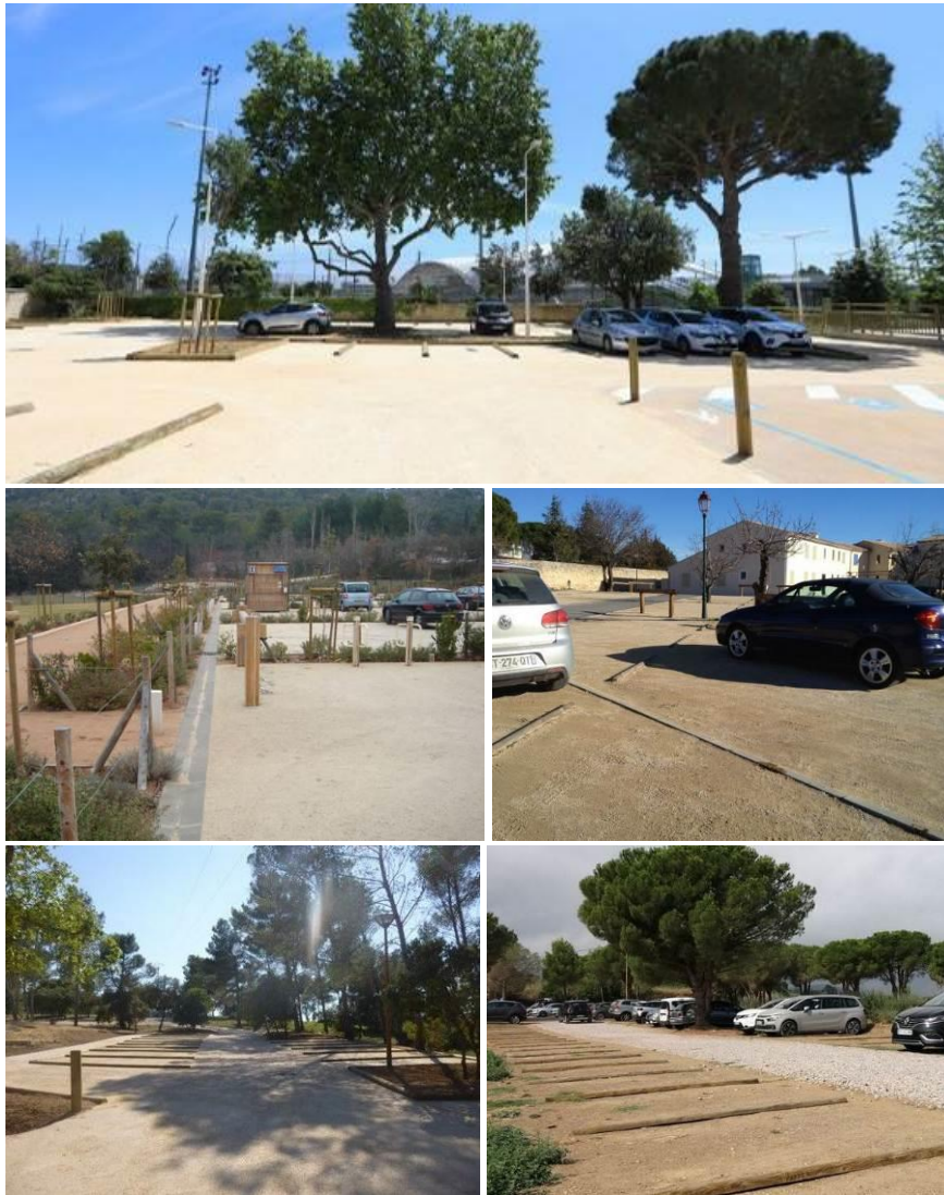
Exemples de stationnements perméables et paysagés
