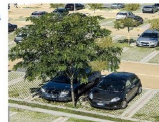
Exemple de parking en milieu périurbain Intégration paysagère des surfaces de stationnement en dalles alvéolées, enherbées selon une technique de prairie sèche assurant la perméabilité des sols et permettant la restauration des fonctions naturelles.
