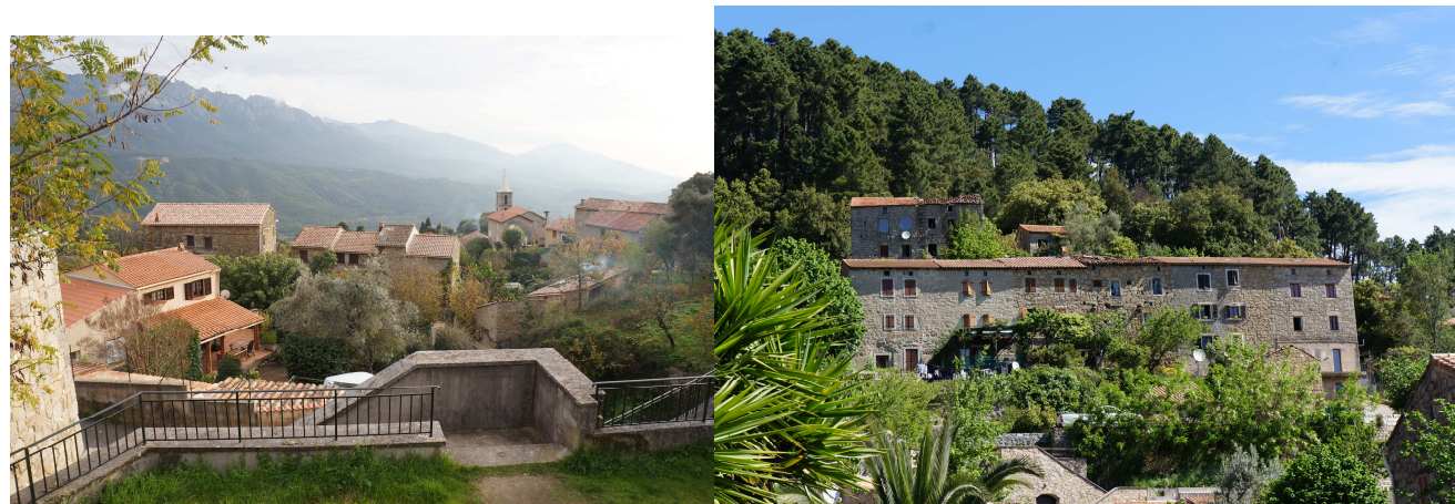
Vue plongeante sur la cinquième façade
