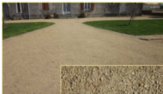
Stabilisé mécaniquement « CHAPE »
