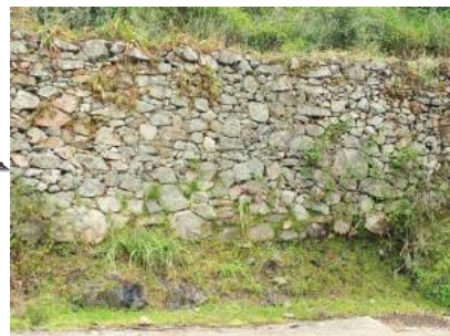
Exemple de murs de soutènement
