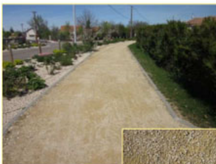
Stabilisé mécaniquement « STABILISÉ CALCAIRE »
