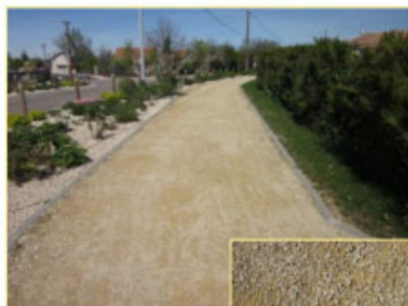
Stabilisé mécaniquement « STABILISÉ CALCAIRE »
