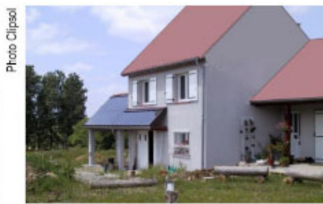
Les capteurs peuvent être utilisés comme des auvents
