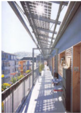
Les capteurs peuvent être utilisés comme des auvents
