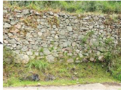
Exemple de murs de soutènement
