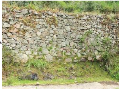
Exemple de murs de soutènement
