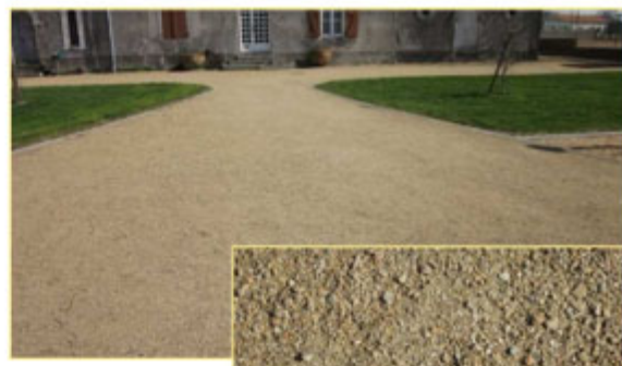
Stabilisé mécaniquement « CHAPE »
