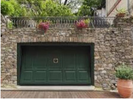
Exemple de toiture terrasse d'un volume enterré
