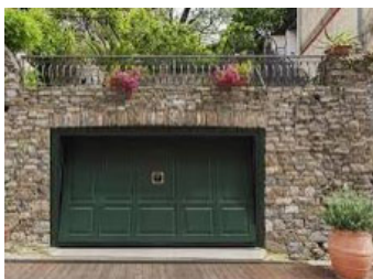
Exemple de toiture terrasse d'un volume enterré
