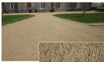
Stabilisé mécaniquement « CHAPE »
