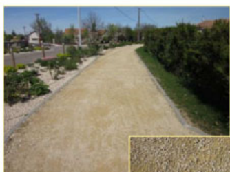
Stabilisé mécaniquement « STABILISÉ CALCAIRE »
