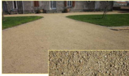
Stabilisé mécaniquement « CHAPE »
