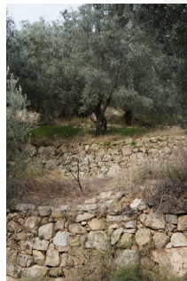
Exemple de murs de soutènement
