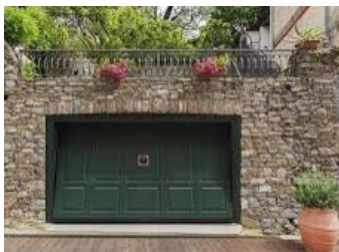
Exemple de toiture terrasse d'un volume enterré
