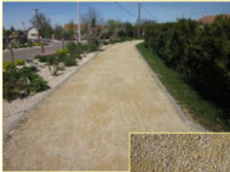
Stabilisé mécaniquement « STABILISÉ CALCAIRE »
