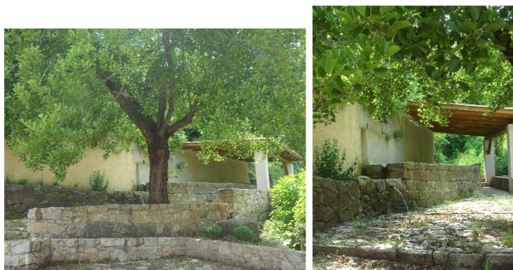
Une rénovation réussie du lavoir : la présence de l'eau, source de fraîcheur qui anime les ambiances du village
