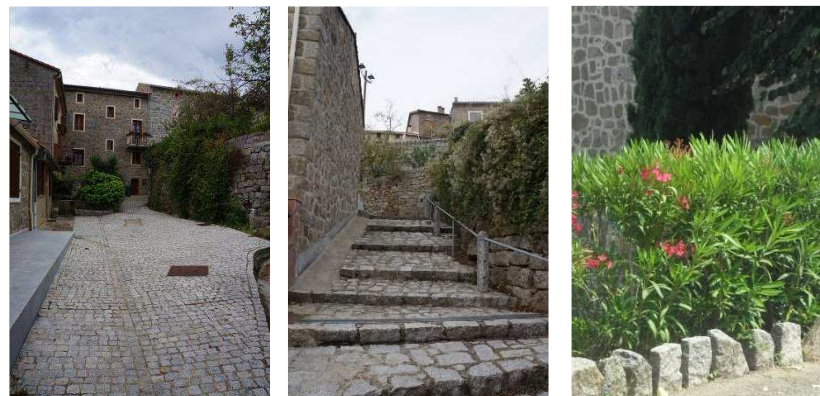
Poursuivre l'utilisation des matériaux locaux
