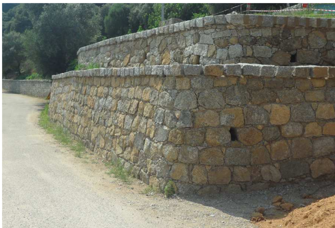
Les travaux en cours améliorent l'entrée du village
